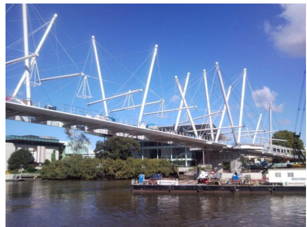
Η γέφυρα Kurilpa στο Brisbane της Αυστραλίας σχεδιασμένη από την ομάδα Cox Rayner Architects
